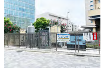
9/30 地下水プラント完成
