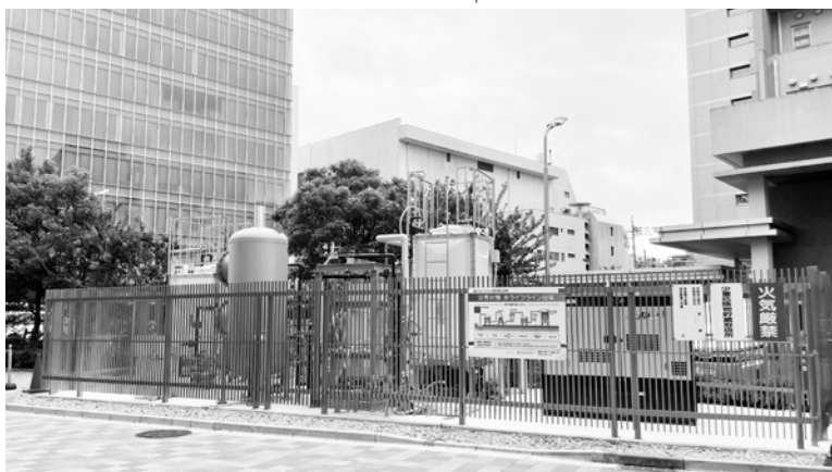
▲地下水プラントの設置
